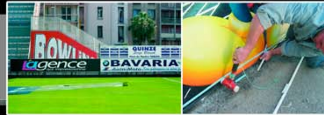
Panneau fixe de stade sur bâche tendue
